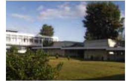
κτήριο Κτηνιατρικής Σχολής Καρδίτσας
